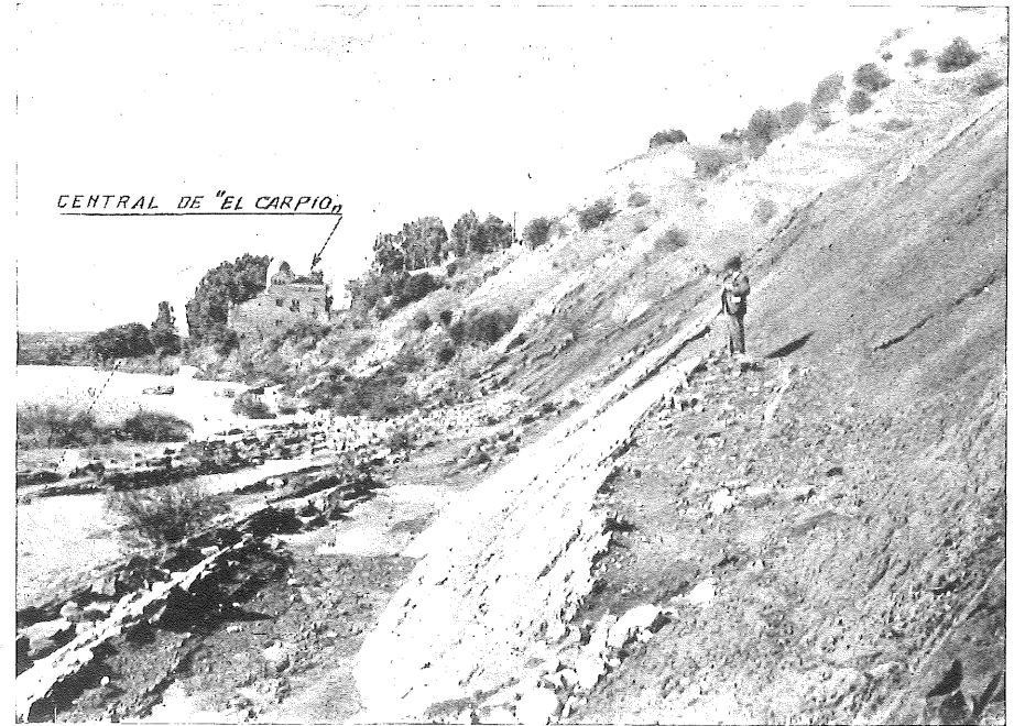
Afloramiento del culm en la orilla derecha del Guadalquivir, aguas arriba de la Central Hidroeléctrica de El Carpio.
